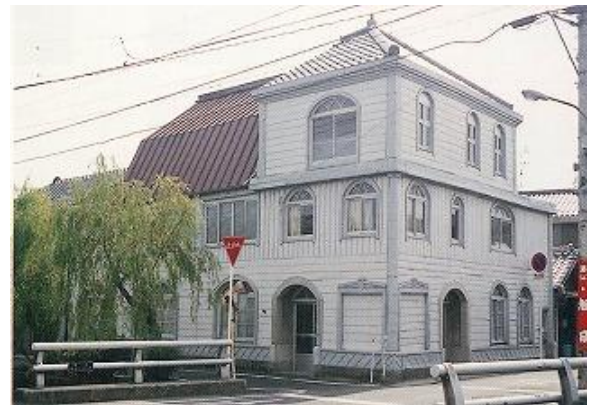
東洋写真館(出雲市)
