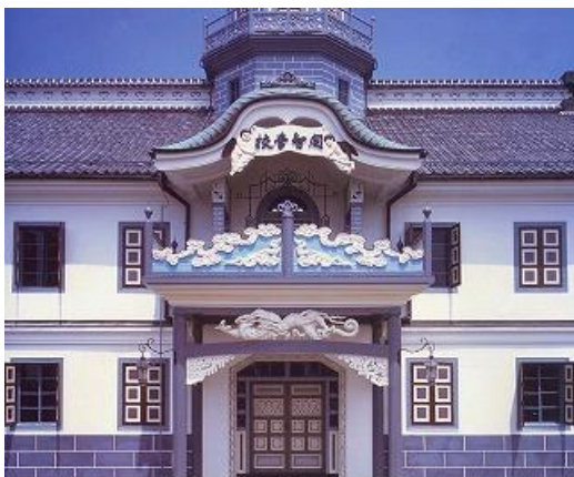
旧開智学校玄関部分
