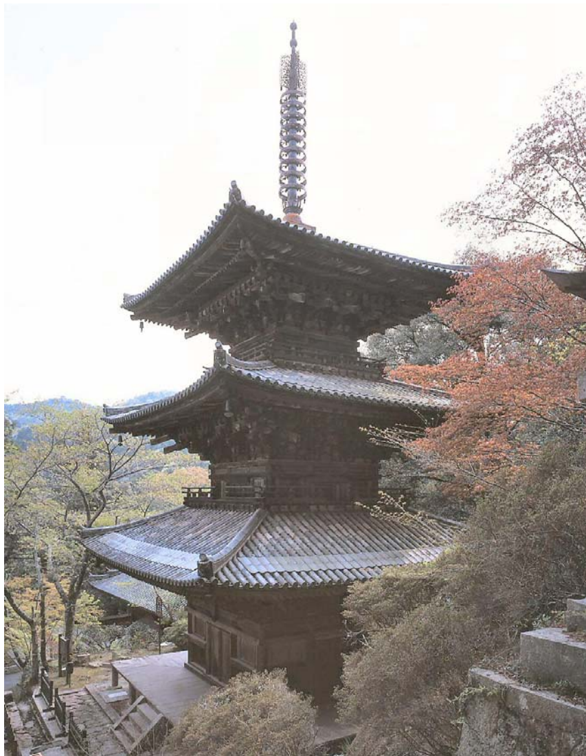
三間三重塔婆 本瓦葺
